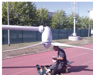
Installation d'une éolienne connectée au réseau
